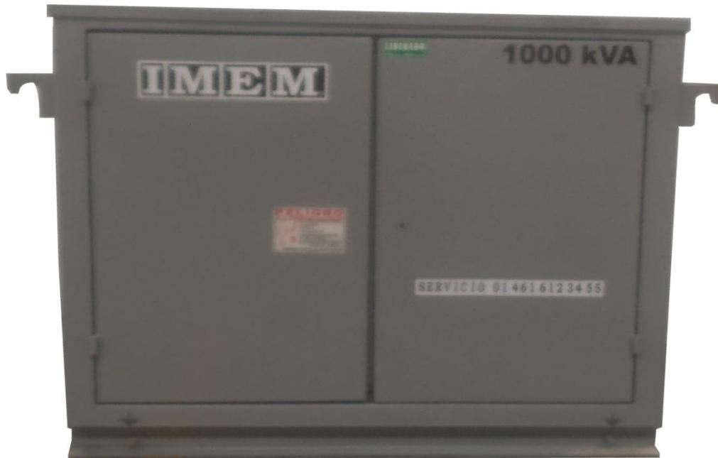
Los transformadores de distribución y potencia tipo seco marca IMEM están conformados por la parte activa nucle-bobinas, sin inmersión en algún líquido aislante y pueden ser del tipo impregnado con barniz al vacío o del tipo encapsulado.
